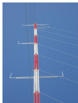
photo 2 : bras de dépôts des anémomètres et girouettes
